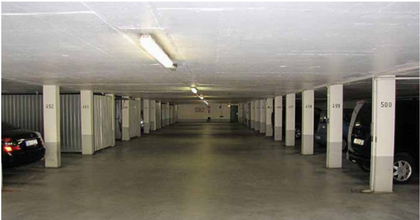
5. Die Tiefgarage nach Abschluss der Sanierung.
