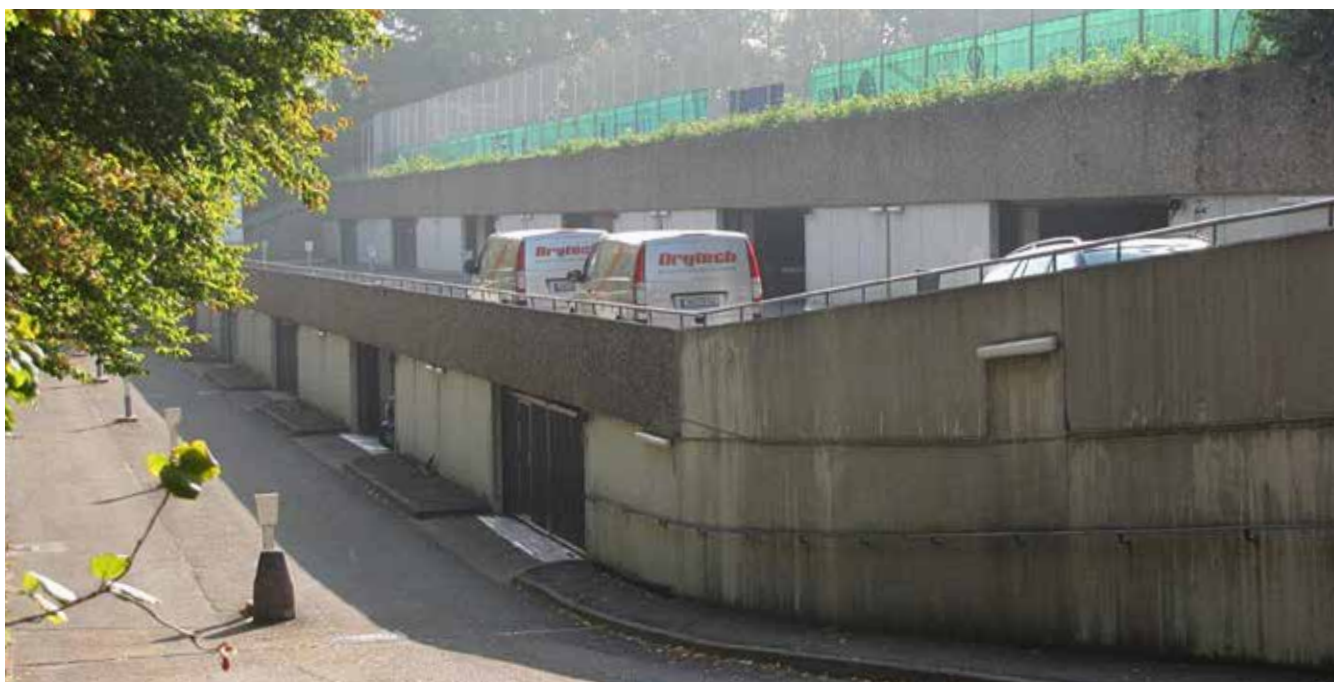
1. Außenansicht der zweigeschossigen Tiefgarage – erkennbar sind auch die über der oberen Parkebene liegenden Tennisplätze.
