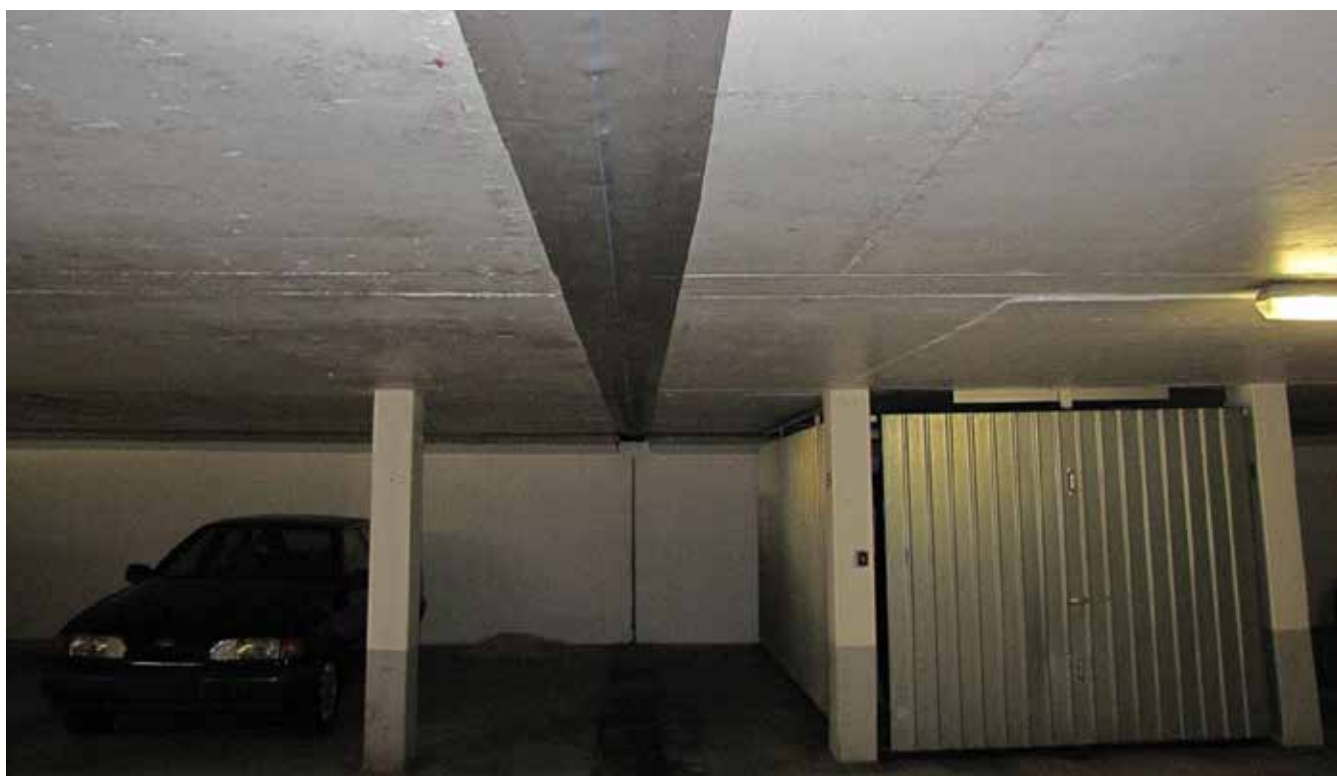
4. Abgedichtete Dehnfuge mit eingeklebtem thermoplastischem Elastomerband (TPE-Band).
