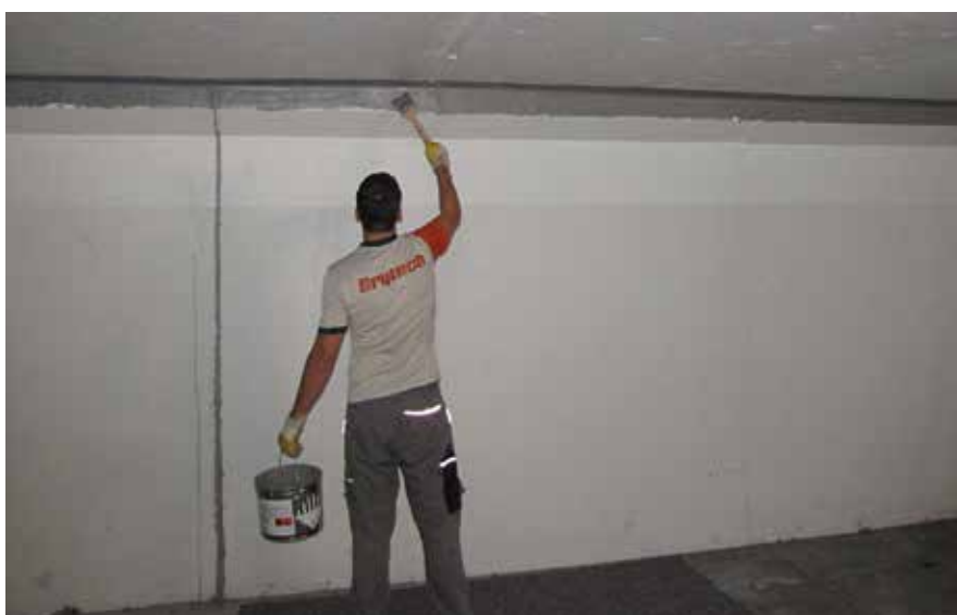
2. Sanierungsarbeiten an einer der Trennwände der Tiefgarage.
