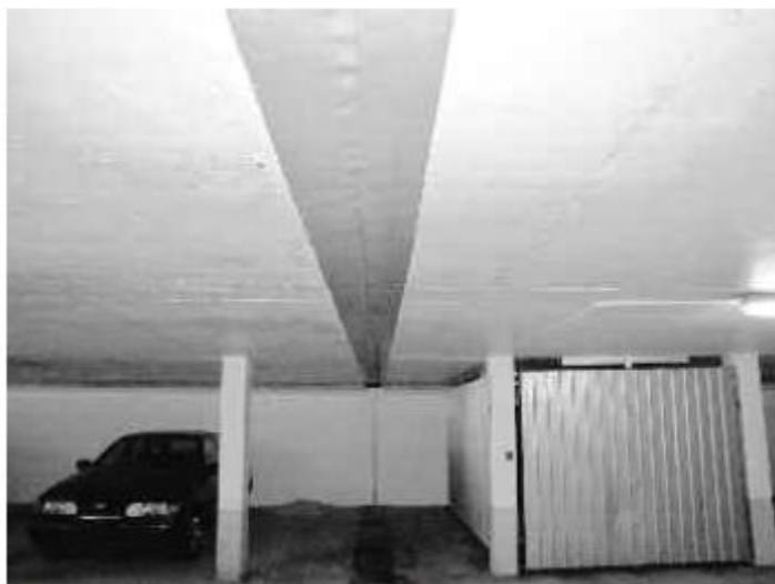
Die abgedichtete Dehnfuge mit eingeklebtem thermoplastischen Elastomerband (TPE-Band).
