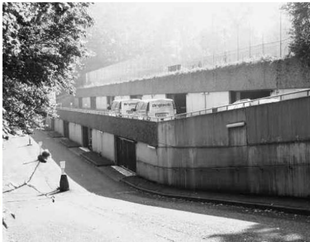
Außenansicht der zweigeschossigen Tiefgarage – erkennbar sind auch die über der oberen Parkebene liegenden Tennisplätze.
