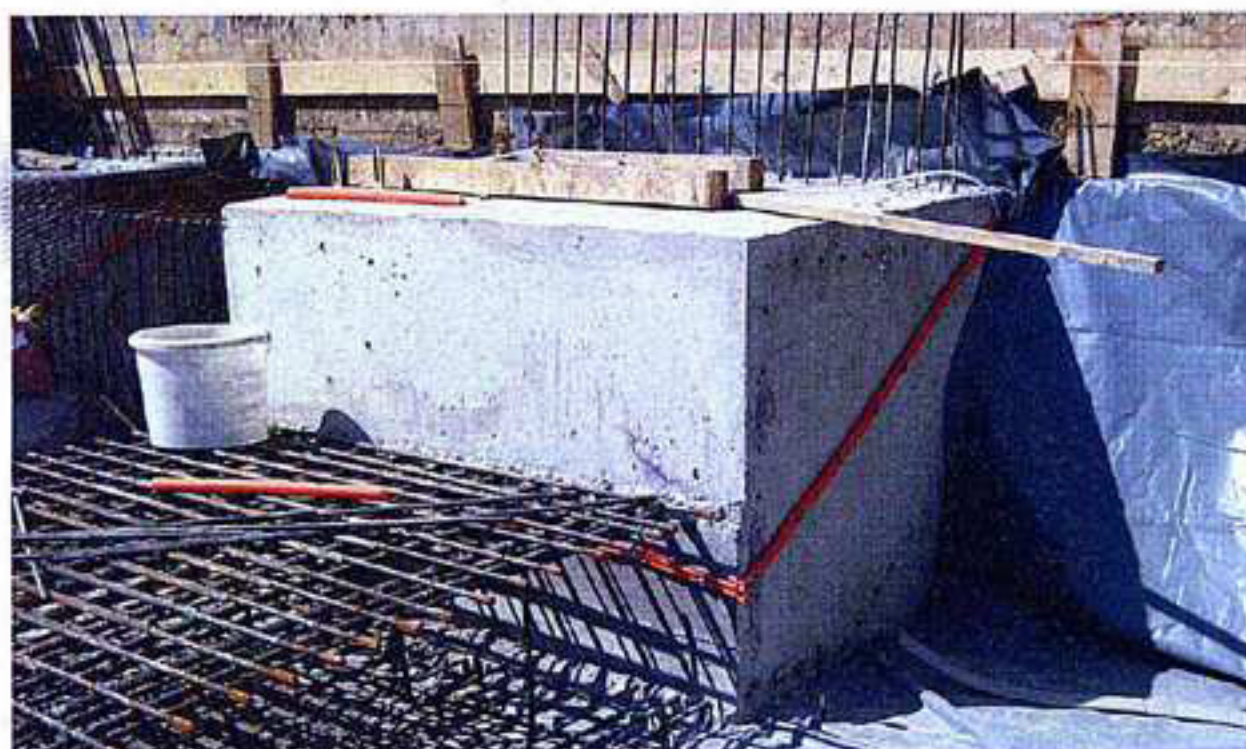
Bild 3: Verlegte Dryset-Elemente im Bereich der Unterfangung. Eine konventionelle Abdichtung wäre hier praktisch undurchführbar gewesen
