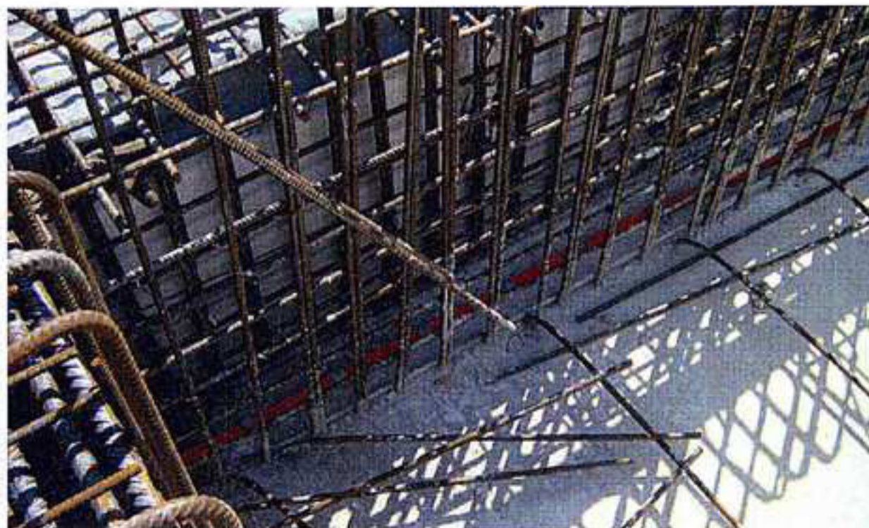
Bild 2: Dryset-Injektionsprofile im Boden-Wand-Anschlussbereich. Die Drytech-Elemente dienen der kapillaren Ausbreitung des Abdichtungsharzes Dryflex
