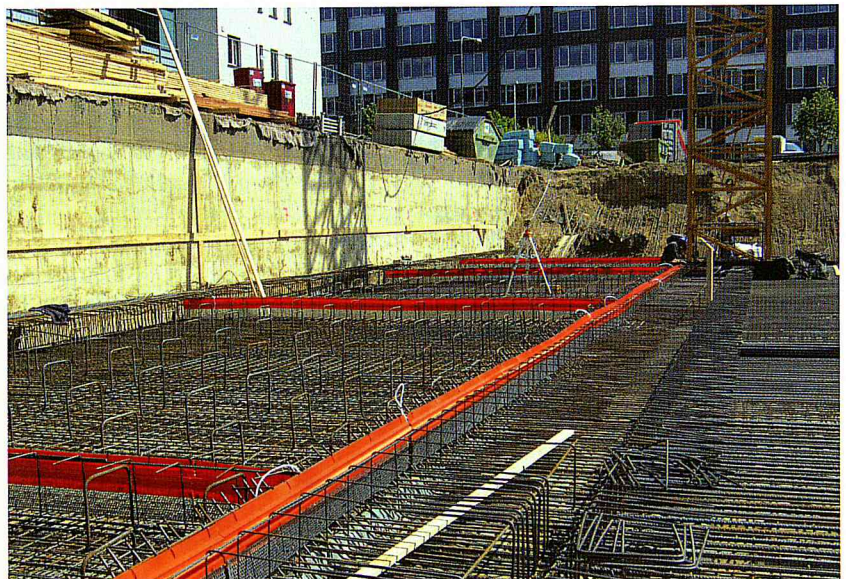
Verlegte DRYset-Sollrissprofile in der Bodenplatte einer zukünftigen Tiefgarage. Ist der Beton ausgehärtet, werden die Bauteilfugen über die Verpressung des Abdichtungsharzes DRYflex vollflächig geschlossen. Foto: Drytech
