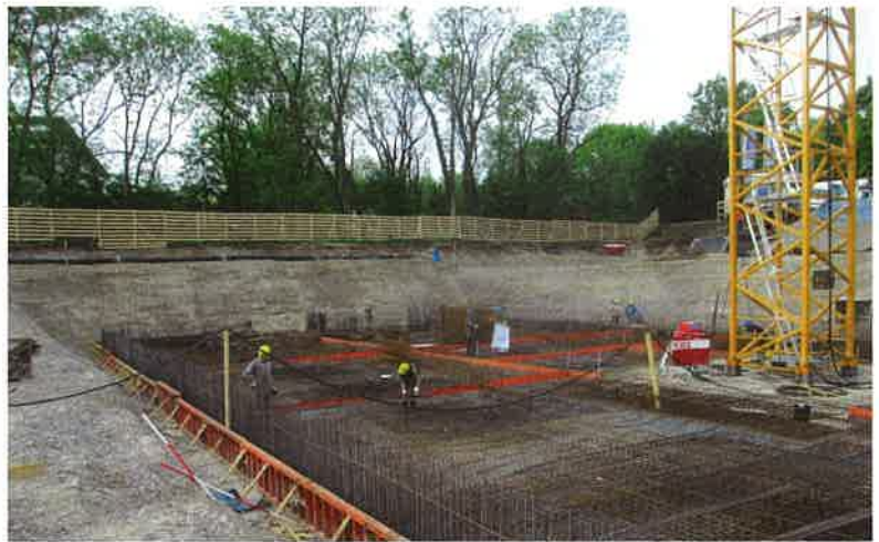
Die DRYset-Sollrissfugenelemente in der Bodenplatte sind Elemente des Abdichtungsplans.
